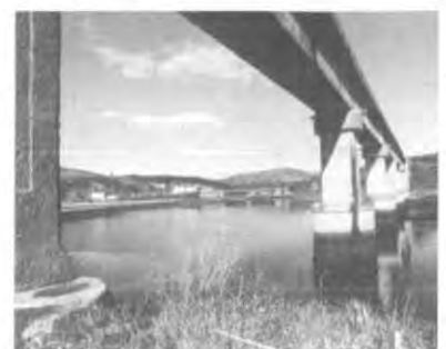
A ponte del ferrocarril y, al fondo, a de Porto, entrambas porriba del Eo (SATSANG)
